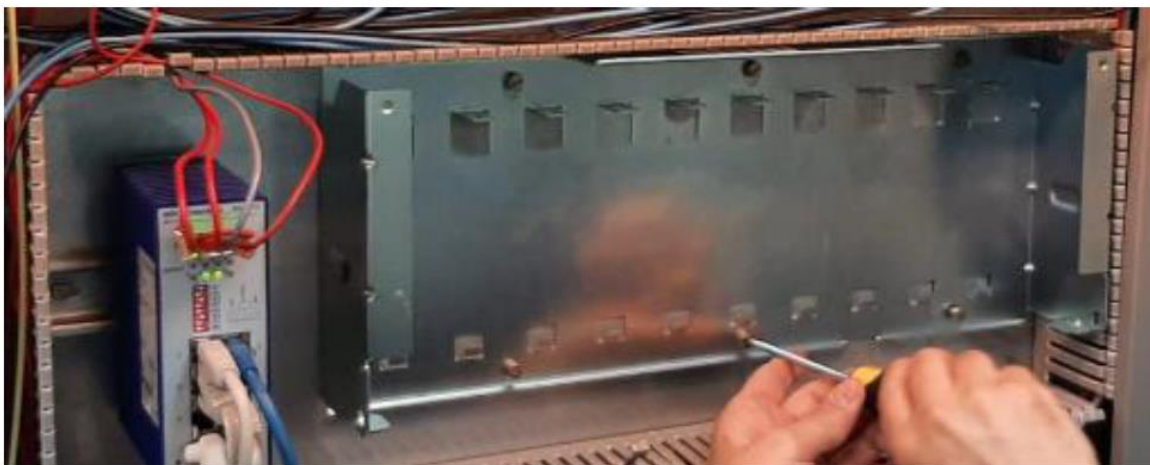
Figura 4-3: Bastidor original SLC 500 i el muntatge del nou bastidor.
