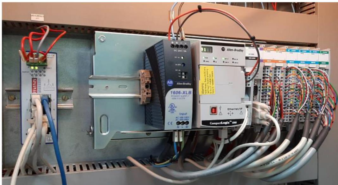
Figura 4-5: Disposició final del nou CompactLogix.
